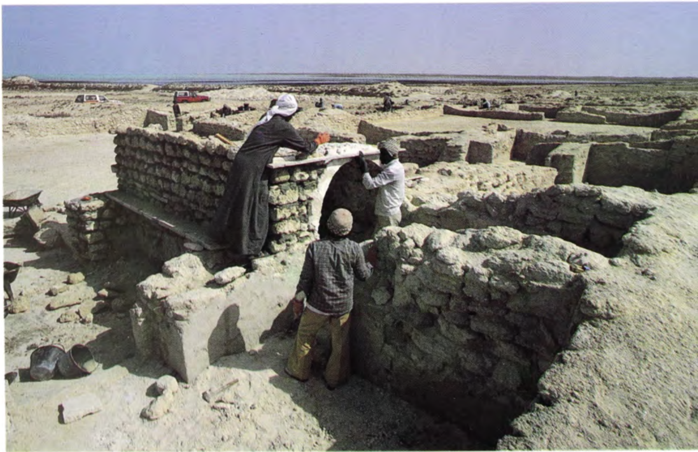
الزبارة - أعمال الترميم في المطبخ رقم ٤ بالبيت الشمالي
